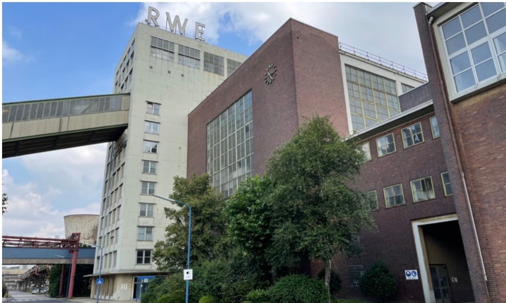
Zentraler Kraftwerksbau, Ansicht Vorderseite
